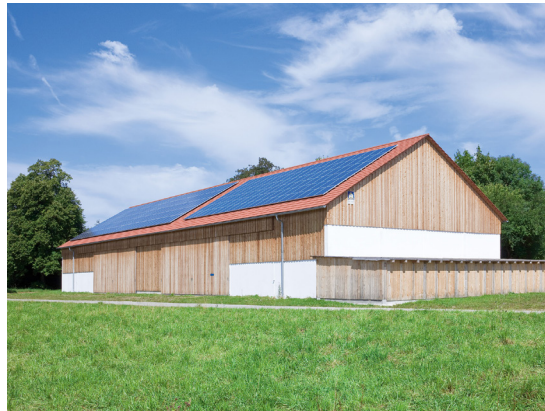
Photovoltaikanlage am Gut Großlappen
