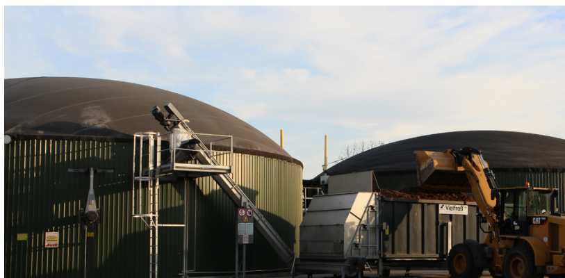
Biogasanlage am Gut Karshof
